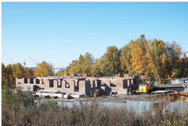
Продолжается строительство поликлиники.
